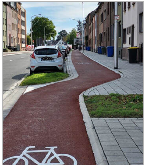
Radweg auf der Westseite, Führung zwischen Parkständen und Gehweg
