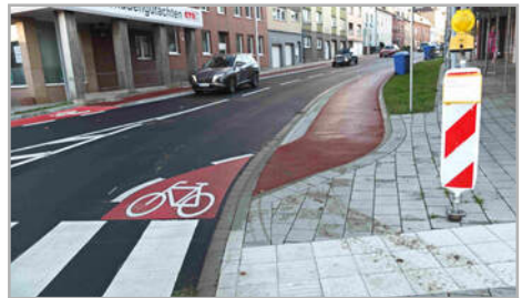
Enge Einfädelung auf den Radweg hinter dem Kreisverkehr in Fahrtrichtung Süd bergauf
