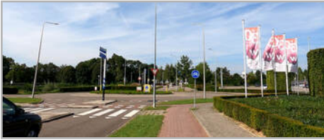
Radwege auf beiden Seiten der Straße
