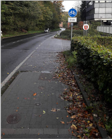
Nachtigällchen, hier wird stadteinwärts ein Radweg gebaut; Beschreibung im Bericht
