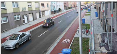
Euskirchener Straße in Fahrtrichtung Süd bergauf, Tempo 30 wurde hier wieder aufgehoben
