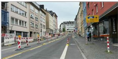
Zudem hat man in der Engstelle die Radfahrstreifen zusätzlich mit Leitschwellen abgesichert - so fährt man während der Baustelle sicherer als zu Normalzeiten.
