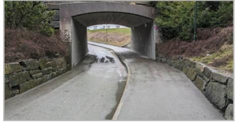
Ein pfiffiges Detail ist noch der Übergang zwischen dem Radweg und dem Gehweg: In Deutschland wird die typischerweise mit einem Randstein umgesetzt mit einem 90°-Winkel. Bei dem Radweg in Kristiansand wurde der Übergang über weite Strecken (nicht in den Tunneln – wieso: keine Ahnung!) mit einem abgeschrägten Randstein gelöst. Das hat den großen Vorteil, dass Radfahrende, die nicht so ganz aufpassen, nicht stürzen, weil der Reifen nicht am Randstein entlang schleift, sondern einfach hochfährt.
