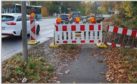
Baustelle auf dem Radweg der Nidegger Straße
