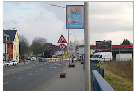
Baustelle an der Kreuzung Schoellerstraße/ Arnoldsweiler Straße
