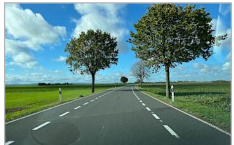
Schutzstreifen zwischen Frauwüllesheim und Irresheim
